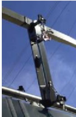
Abstrebung für Abspannungstangen
